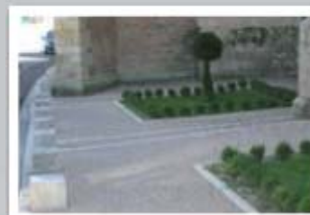
Aménagement de parvis d'église (Fieurance)
