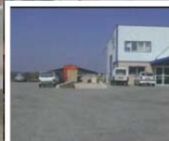
Aménagement de site industriel (JCB Aéro - L'Isle Jourdain)
