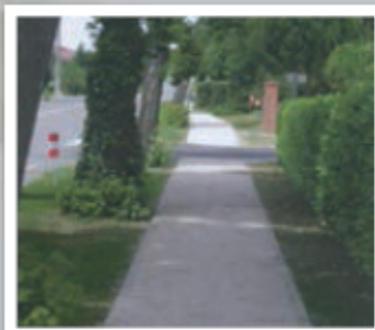
Aménagement de voie piétonne (Mauvezin)
