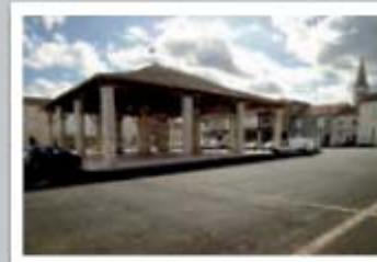
Aménagement de place (Solomiac)
